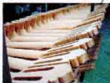
FERTIGE HÄLSE VOR DEM EINBAU
